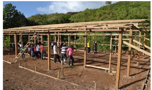
Nouvelle école en construction en mai 2016
